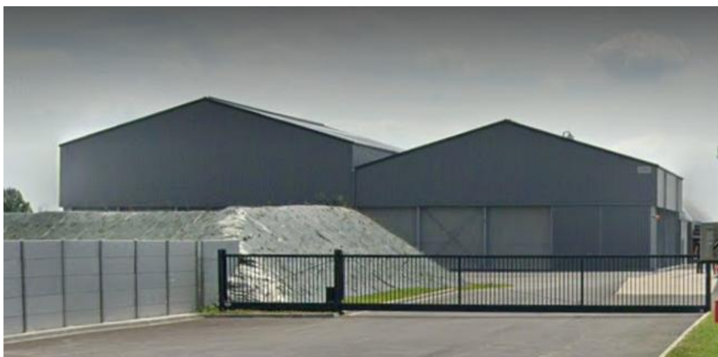
Figure 3 : bâtiment de droite correspondant au stockage de digestat phase solide
